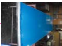
アルポリ板 リベット固定
