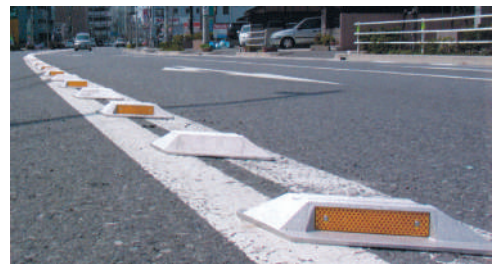
チャッターバー S4517S 施工例
